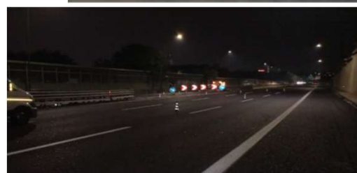
La sicurezza delle gallerie della rete stradale transeuropea: importanza dei sopralluoghi e delle attività ispettive
