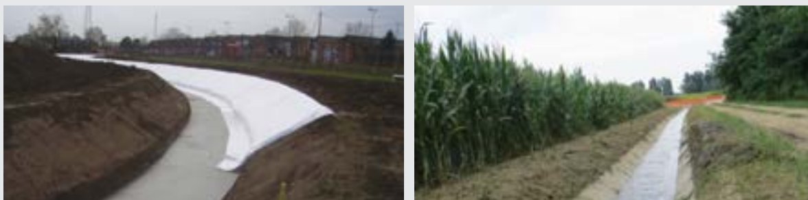
Figura 3.6 – Vie d'Acqua lavori in corso - Cantiere Via d'Acqua Nord
