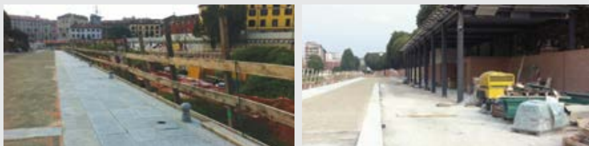
Figura 3.5 – Vie d'Acqua lavori in corso - Cantiere Darsena
