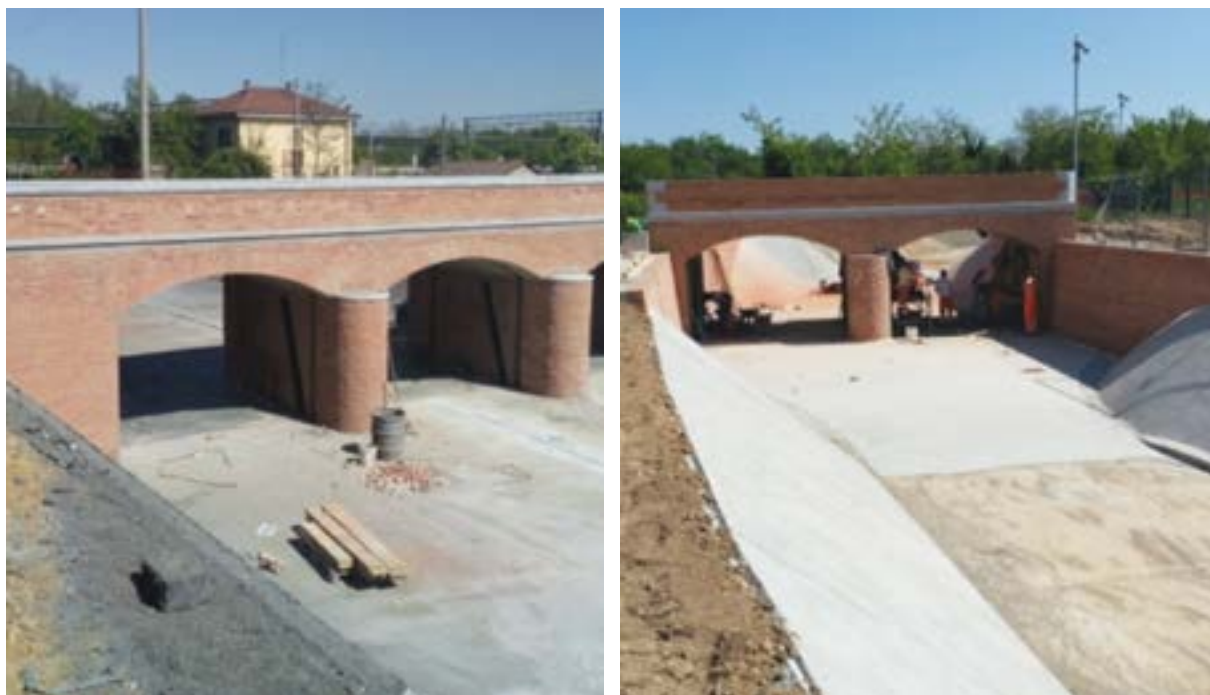
Figura 3.4 – Vie d'Acqua lavori in corso - Cantieri sul Canale Villoresi
