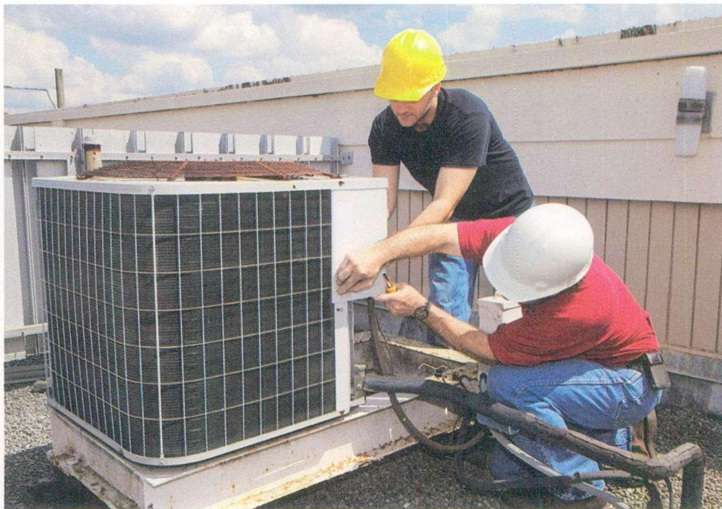
Un intervento su un impianto di condizionamento
